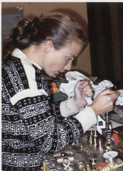
Une jeune participante à un chantier didactique en plein travail...
