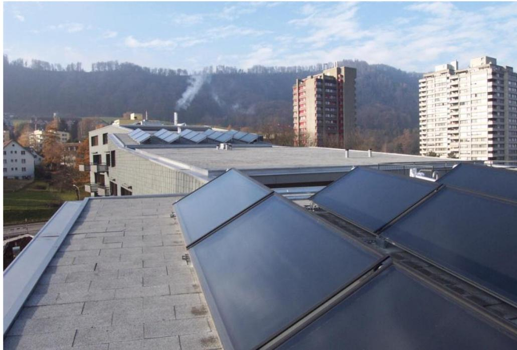
Une installation de préchauffage de l'eau chaude sanitaire réalisée avec des capteurs industriels à la queue-leu-leu, un simple chauffe-eau en cave. C'est le plus simple et ca rapporte le plus et on se casse pas le cul.
