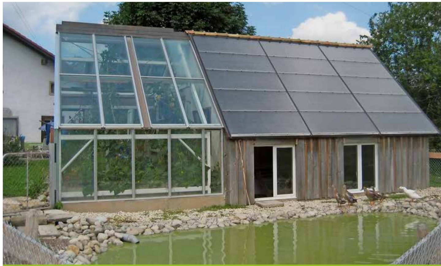
Aux Breuleux, en été, on dispose de 4500 litres à 90 degrés. La serre a pu être construite grâce au solde positif.
