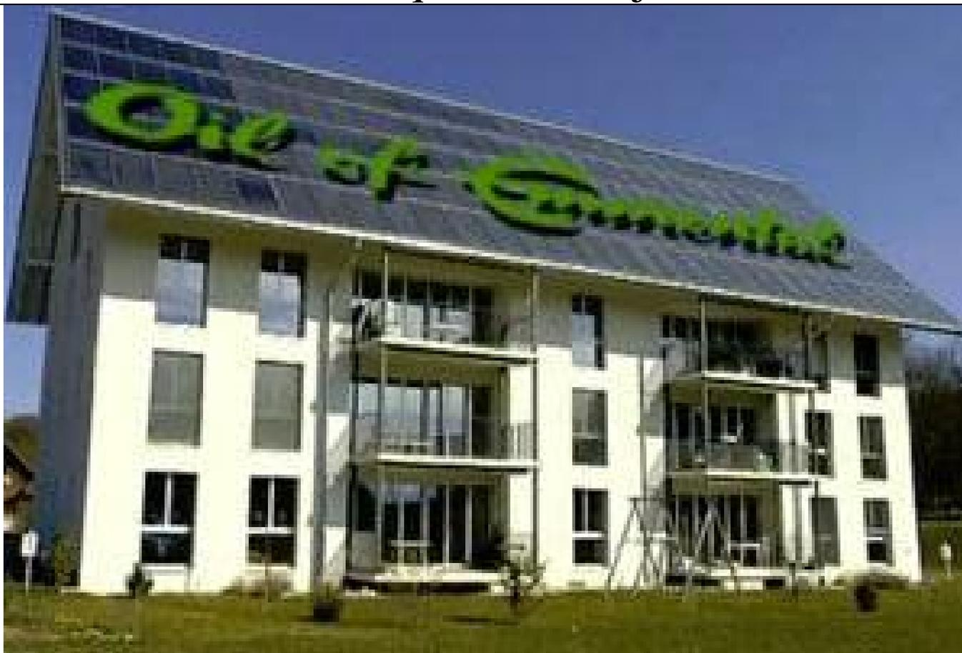
100% solaire, aucune chaudière - 150m<sup>2</sup> de capteurs, 100'000L d'accu
