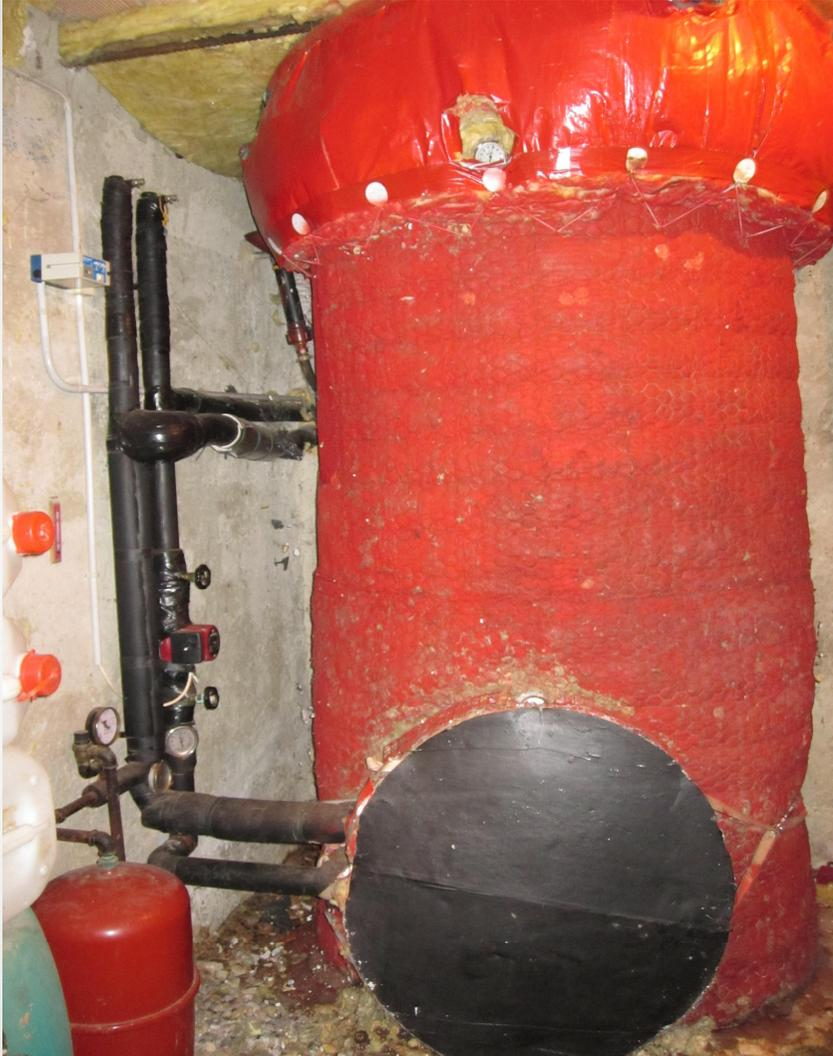
Citerne de récupération de 1 m<sup>3</sup> avec l'arrivée de l'eau chaude et le départ de l'eau froide vers les panneaux, le circulateur et le régulateur « Solar Control », le vase d'expansion et le trop plein.
