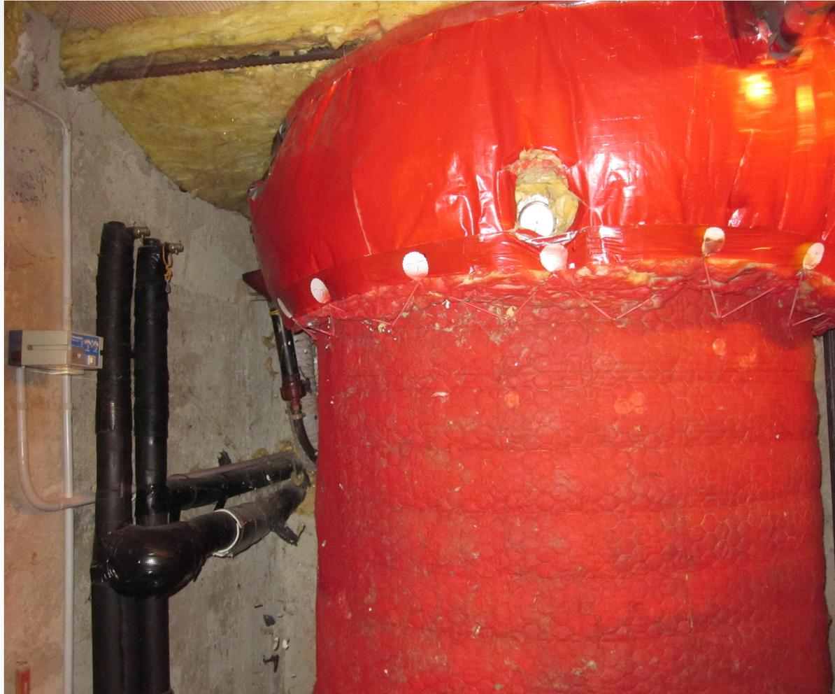
L'eau circulant des panneaux à la citerne contient de l'antigel. Le circuit sanitaire est séparé:
