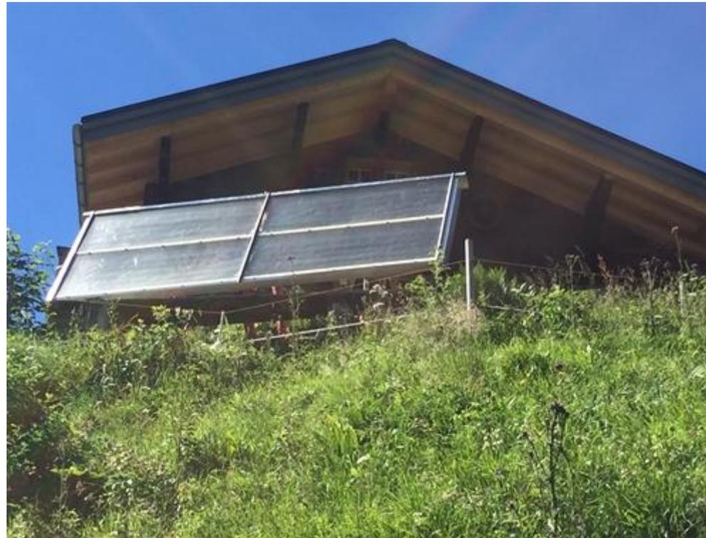
450 kWh produits en février 2019 – max 23 kWh par jour – 3.83 kWh par m<sup>2</sup> –
