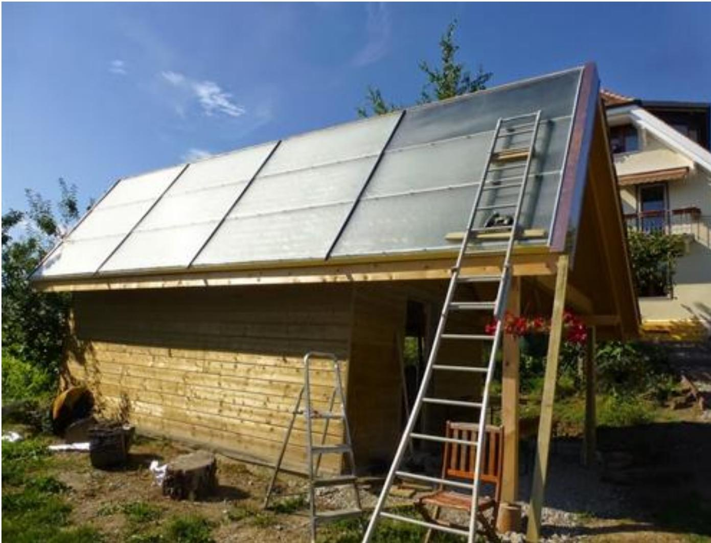
Lavanchy, Lutry. Rénovation. 150m<sup>2</sup> chauffés. 5 personnes. Solaire thermique 18m<sup>2</sup> (2016), + 6m<sup>2</sup> (2003), poêle hydro 10 kW 30/70%  $\eta$  80%, distribution normale + à thermosiphon, radiateurs. Machines à laver & sèche-linge sur solaire thermique **COP 25. Puissance électrique de pointe : 50 W.** Bois ~ 2 stère/an **mesuré sur 3 ans**
