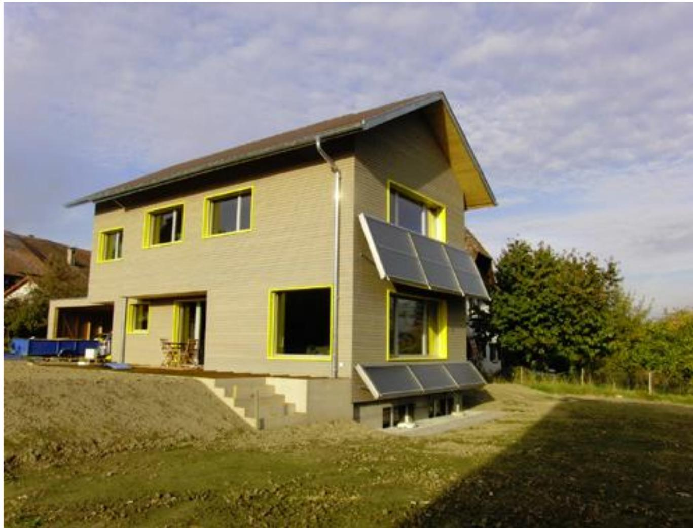
Galliker, Missy. Minergie-P à neuf. 205 m<sup>2</sup> chauffés. 5 personnes. Solaire thermique 13.5m<sup>2</sup>, poêle hydro 8kW 30/70% η 82%, distribution évoluée, ventilation double flux. **Puissance électrique de pointe : 55W**. Bois ~ 1 à 1.5 stère/an **mesuré sur ~ 5 ans**.
