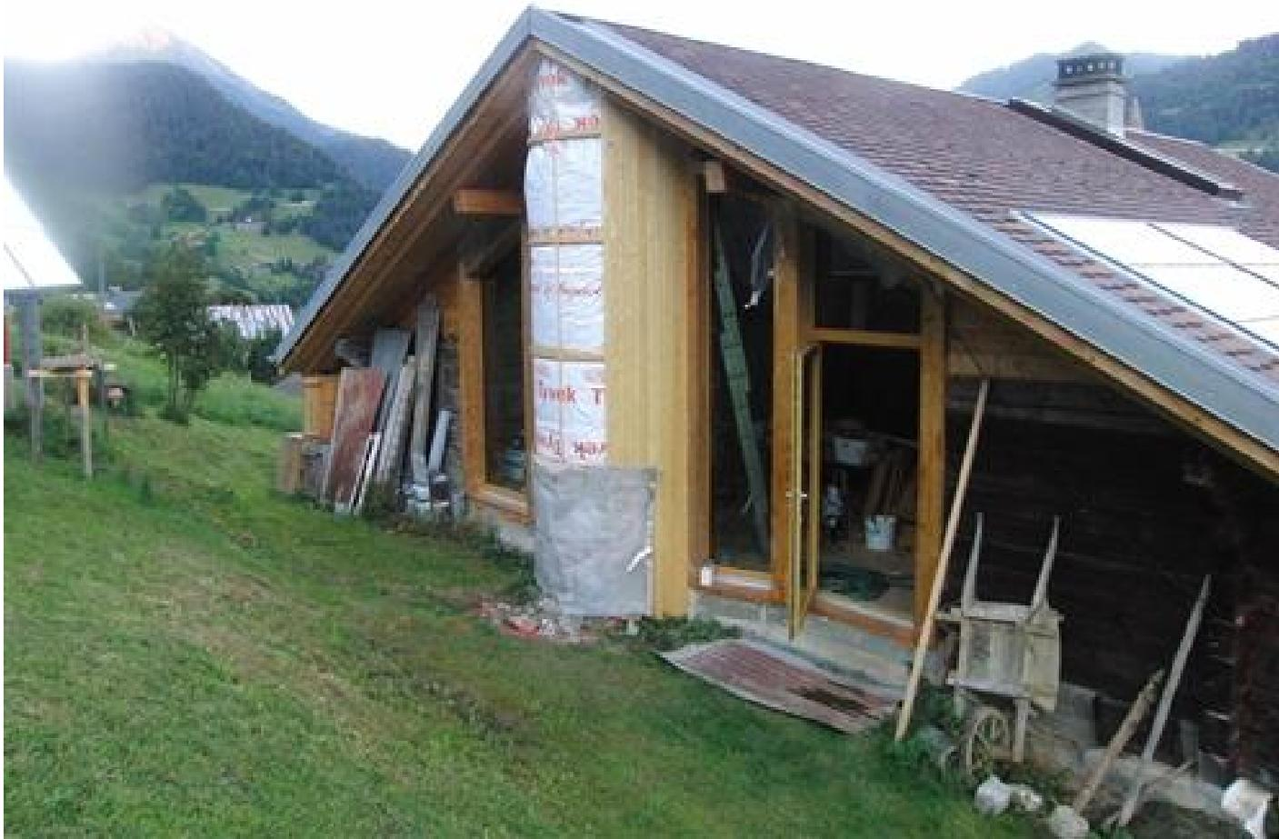
Rettig, Cergnat. Rénovation. 200 m<sup>2</sup>. 4 personnes. Solaire thermique 36m<sup>2</sup> (2012)+ 7.8 m<sup>2</sup> (1999), poêle de masse, distribution évoluée, radiateurs. **Puissance électrique de pointe ~ 50 W.** Bois ~ 1.5 stères/an **mesurée sur ~ 3 ans.**
