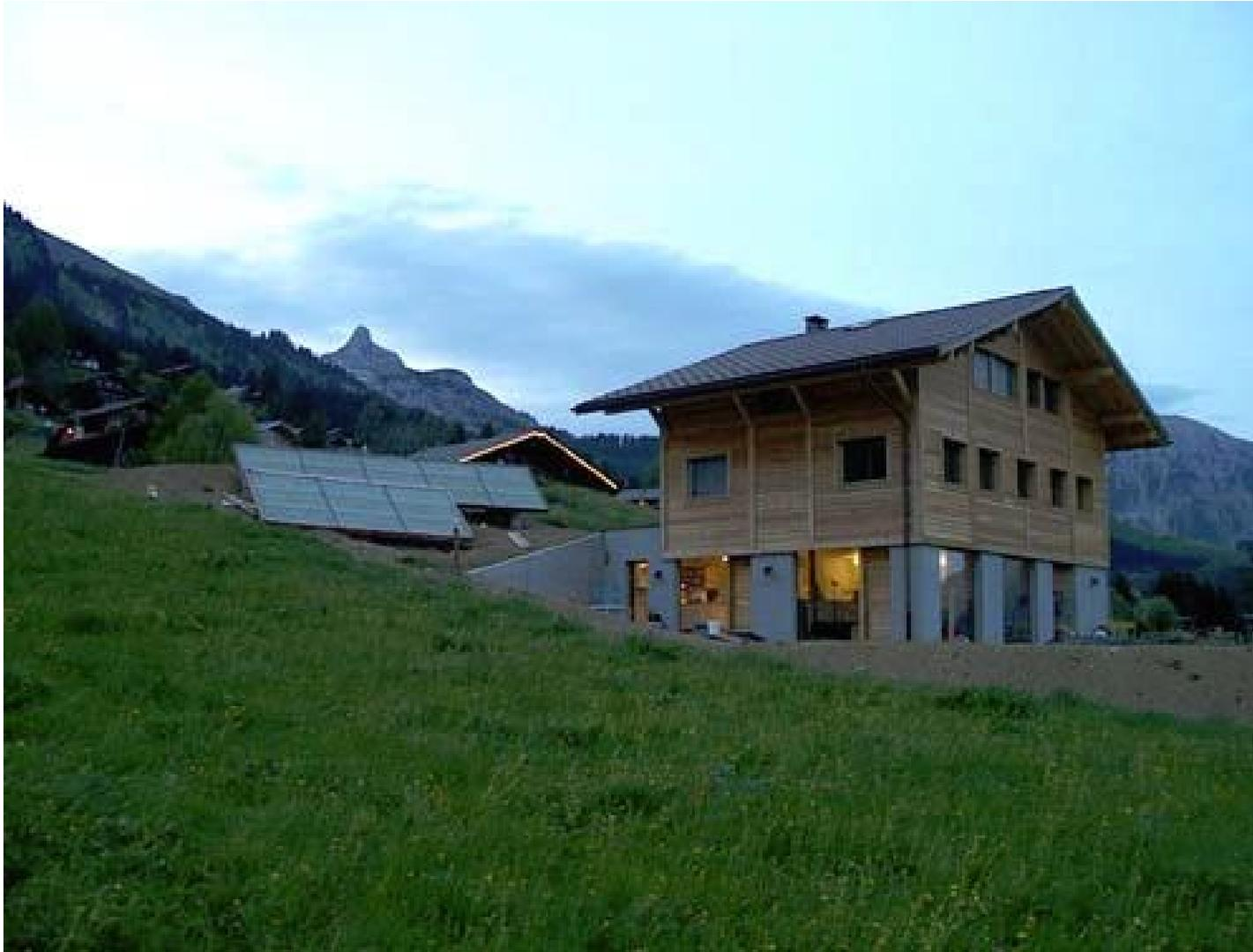
Dulex, Leysin. A neuf. 340m<sup>2</sup> chauffés. 4 personnes. 36m<sup>2</sup> solaire thermique, poêle hydro 11 kW ?/ ? %,  $\eta$  ?%, distribution au sol. **Puissance électrique de pointe : 65 W**. Bois ~ 3 stère/an **mesuré sur 5-10 ans**
