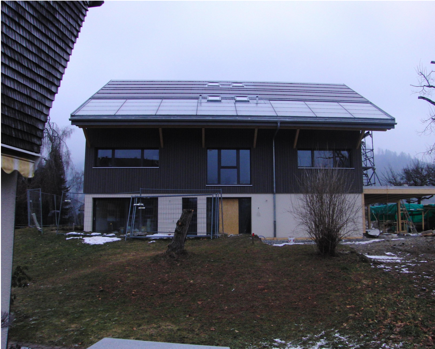
2018 - Bernard Beaud – Autoconstruction (OUI !)
