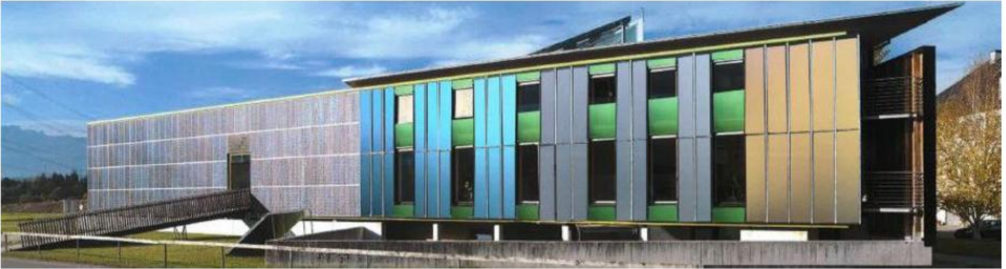
Thermal façade Austria
