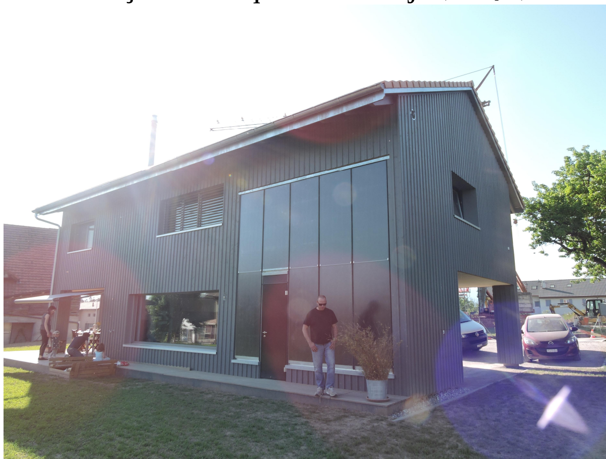
Installation Marmy, Forel FR - Clef-en-main Rhyner énergie Sarl/ Sebasol/ Michel Carron - 2020 Le champ de capteurs encadre la porte
