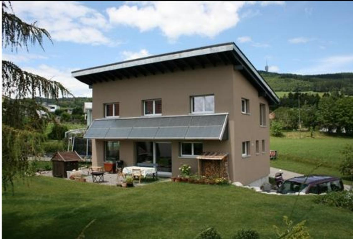
Sorrens. Neuf Minergie-P. 120m<sup>2</sup> chauffés. 15m<sup>2</sup> solaire thermique. Poêle hydro 10kW 30/70%,  $\eta$  80%. Distribution évoluée, chauffage au sol. Ventilation low tech. Couverture solaire > 80%. Bois < 1 stère/an **Mesuré sur 3 ans**. 6 personnes (2020) => ~ 0.15 stères / personne an **OUI**. **Puissance électrique max systèmes vitaux ~ 40 W**. Consommation électrique 2175 kWh/an => 362 kWh/personne an (~ 40% SIA 380/1) **NON**.
