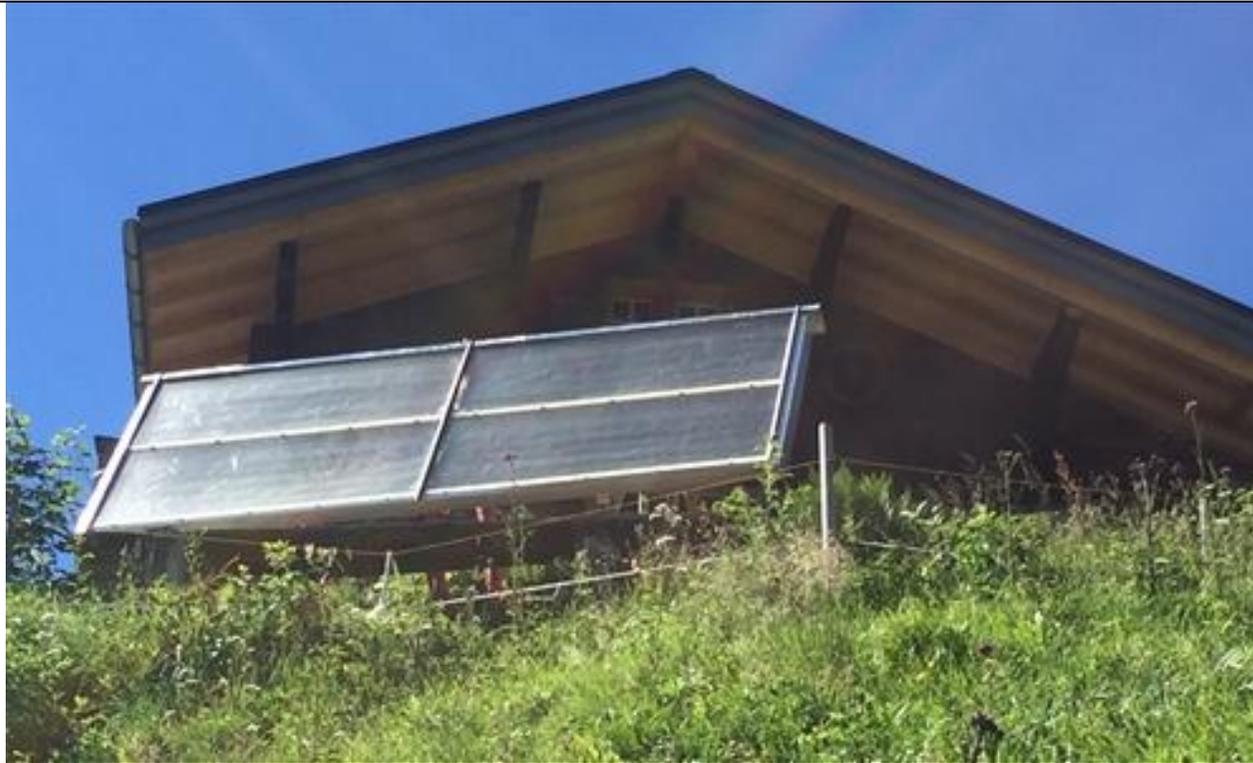
**Quelque Part.** Occupation 110 jours/an. **20 places.** 6m<sup>2</sup> de solaire thermique, poêle hydro 8 kW 30/70%  $\eta$  84%, batteries 2.64 kWh  $\Leftrightarrow$  0.13 kWh / place, 3 m<sup>2</sup> photovoltaïque (0.53 kWc)  $\Leftrightarrow$  0.15 m<sup>2</sup> /place, Conso électrique non occupation 0.5 kWh/jour, 0.025 kWh/place  $\Rightarrow$  9 kWh/ place an, combustible : bois 1400 kWh/ an  $\Rightarrow$  70 kWh/ place an  $\equiv$  0.035 stères/ place an **OUI**.
