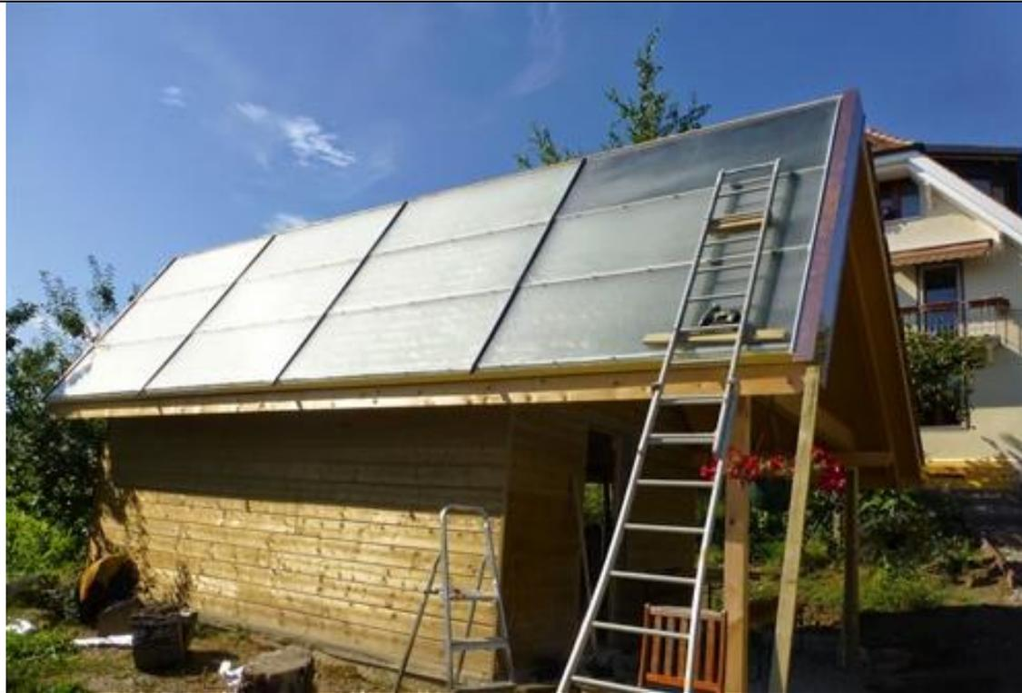
Lutry. Rénovation sur 20 ans. 150m<sup>2</sup> chauffés. Solaire thermique 18m<sup>2</sup> (2016), + 6m<sup>2</sup> (2003), poêle hydro 10 kW 30/70%  $\eta$  80%, distribution normale + à thermosiphon, radiateurs. Bois 2 stère/an **Mesuré sur 3 ans** 5 personnes (2020) => ~ 0.4 stères / personne an **OUI**. **Puissance électrique max systèmes vitaux ~ 50W**. Consommation électrique 2'200 kWh/an => 440 kWh/personne an (~ 50% SIA 380/1) **NON**.
